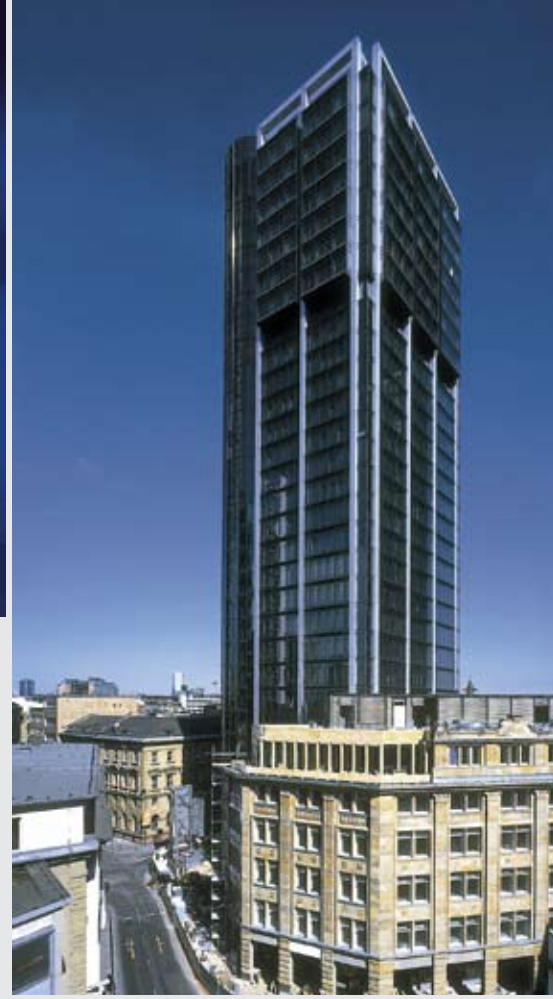
Eurotherm binasında Roth ısıtma ve soğutma sistemi, Frankfurt
