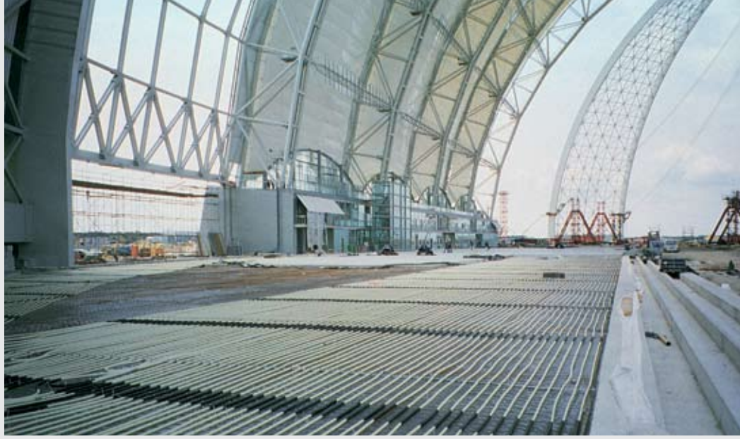
Roth boru taşıyıcı element sistemi, Cargo Lifter uçak imalathanesi, Brand
